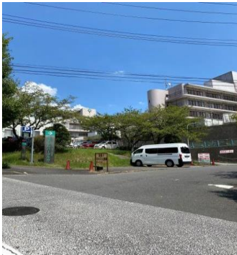
ア [A]地点の写真 (横浜総合病院と横浜シルバープラザ)
