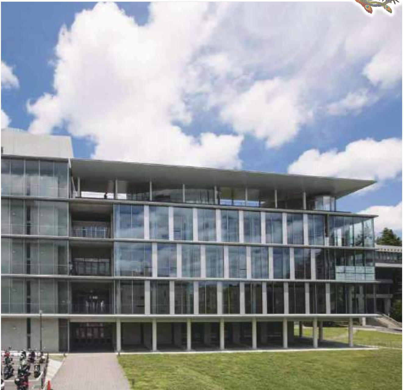
桐蔭横浜大学 中央棟
